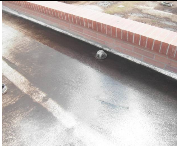
Problemas con la evacuación de aguas lluvias en placa segundo nivel grado Transición
