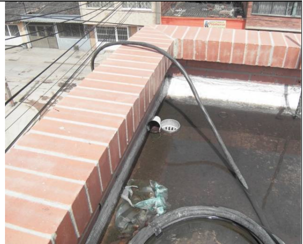
Problemas con la evacuación de aguas lluvias en placa segundo nivel grado Transición
